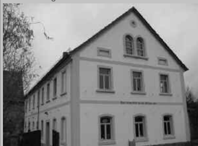
In der Gemeinde Wermisdorf baute ein Unternehmer mit Hilfe der ILE-Förderung einen leer stehenden Dreiseithof als Standort für seinen Gewerbebetrieb aus.
