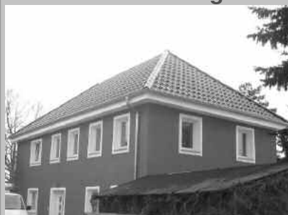
In der Gemeinde Naundorf nutzte eine junge Familie die Möglichkeit der ILE-Förderung für die Sanierung eines leer stehenden Dreiseithofes.
