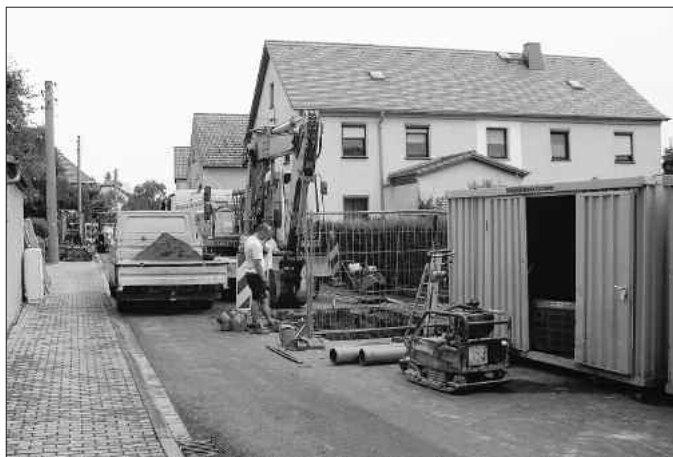
Neubau Abwasserkanal in Collm, Oberweg durch die Firma ADW
