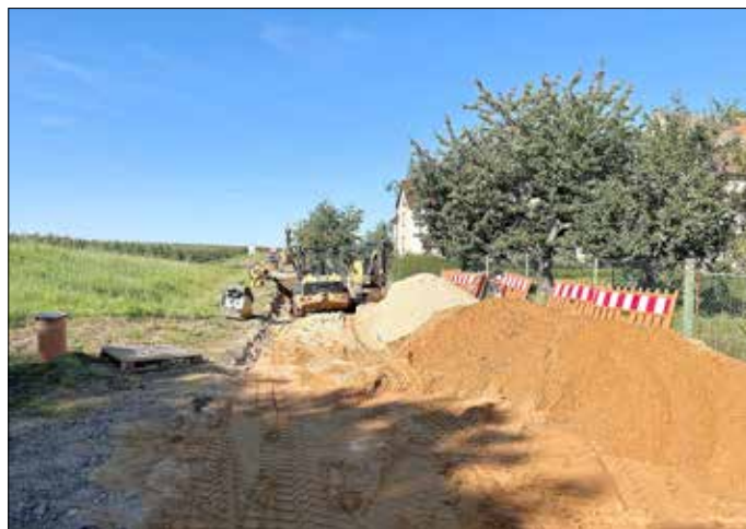
Straßen- u. Kanalbau Liptitz, Hauptstraße
