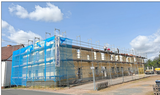
Umbau ehemalige Grundschule zur Kita in Mahlis
