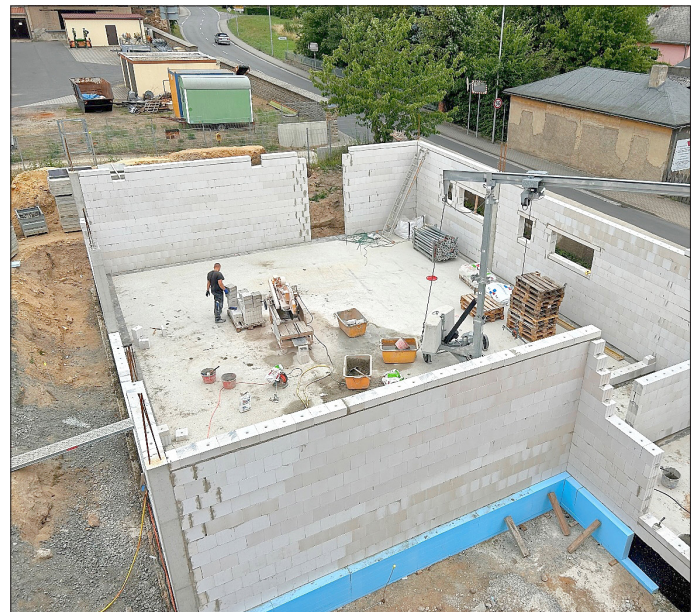
Anbau Hort Wermisdorf
