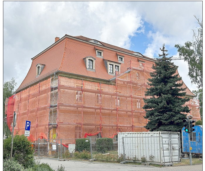
Sanierung Hort Wermisdorf - Alte Poststation
